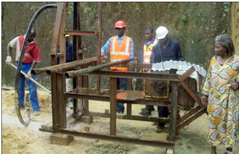
Bohrarbeiten nach Wasser © Waltraut Biester
